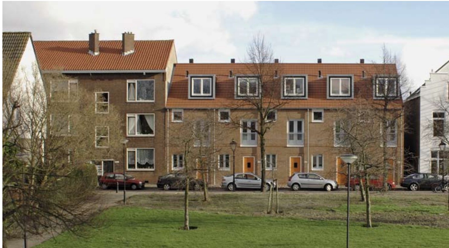
Vijf woningen in Rotterdam Zuidhoek
