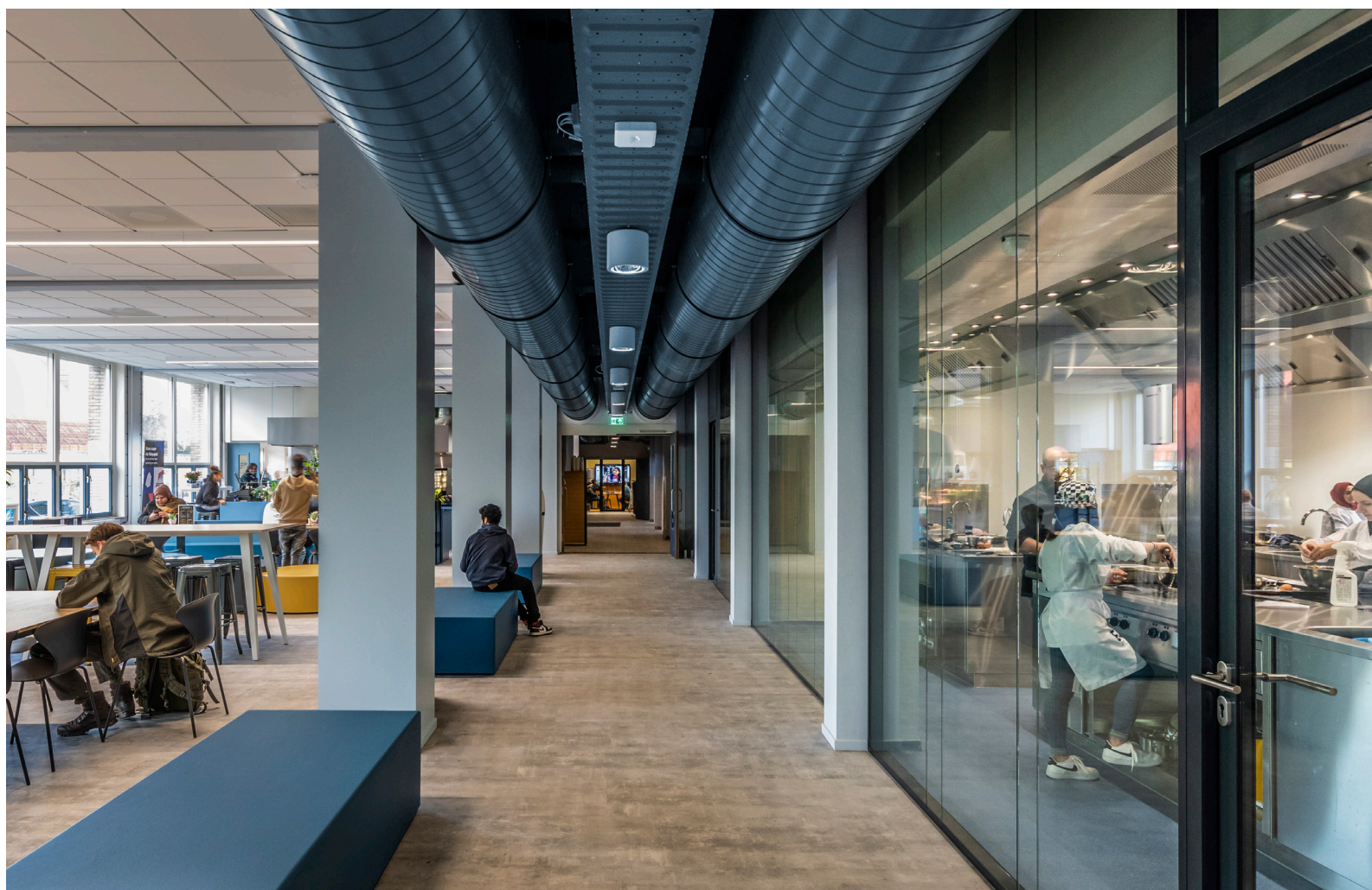
De school moest duurzaam worden en gezond. Daarvoor moesten er ventilatiekanalen worden aangebracht door het hele pand.
