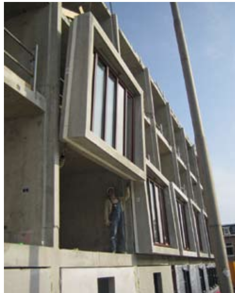
Gevelvullende betonnen prefabelementen, Brasserskade in Delft
