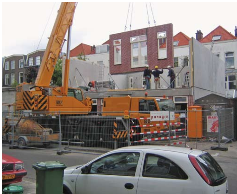
Volledige prefab metselwerk gevels met een betonnen binnenblad, Elandstraat in Den Haag
